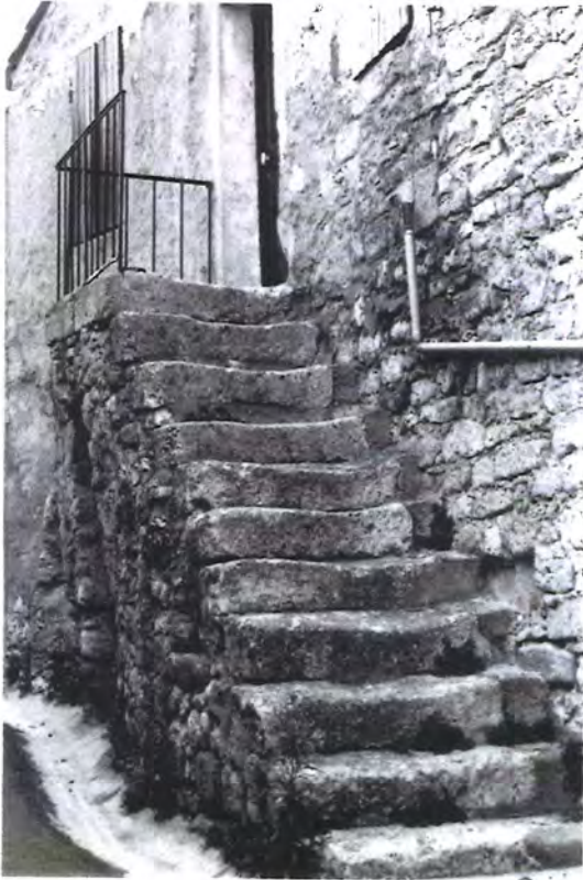
Escalier qui a gardé ses pierres d'origine usées par le temps.
