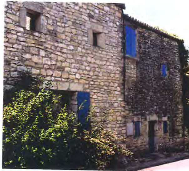
Maisons restaurées du village qui ont gardé leur façade d'origine avec peu de percements de petites tailles.
