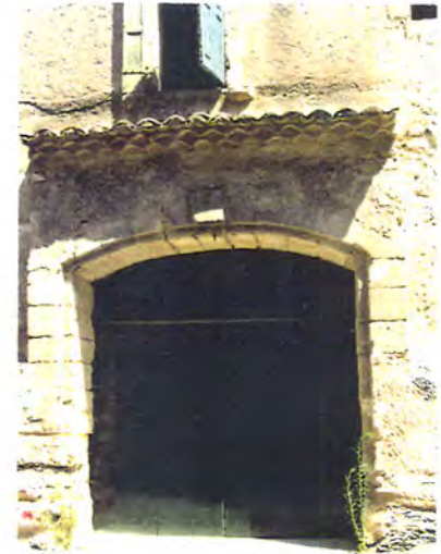
PARCELLE N° 56, de 1772, avec un linteau à clé et une génoise au dessus du portail.
