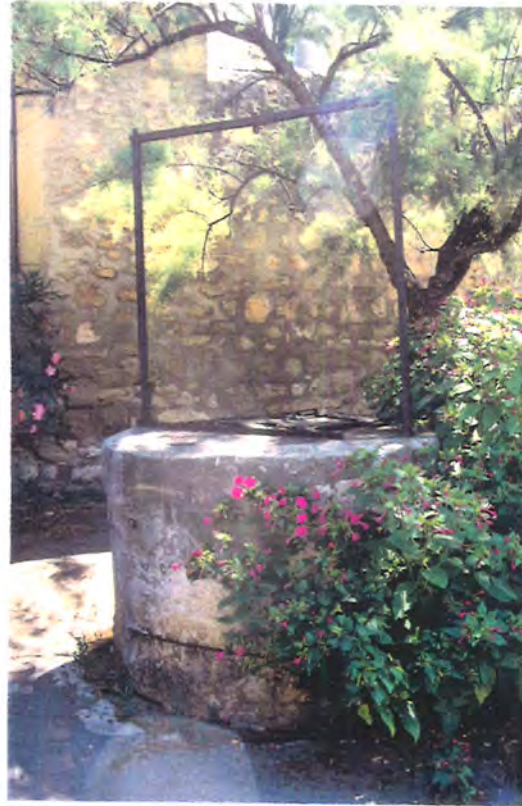
Puits rond, sur la place du four, toujours en activité
