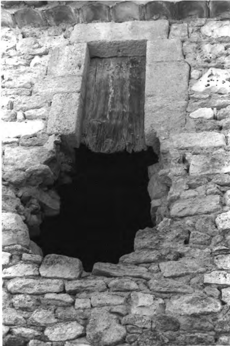
Rue du porche
