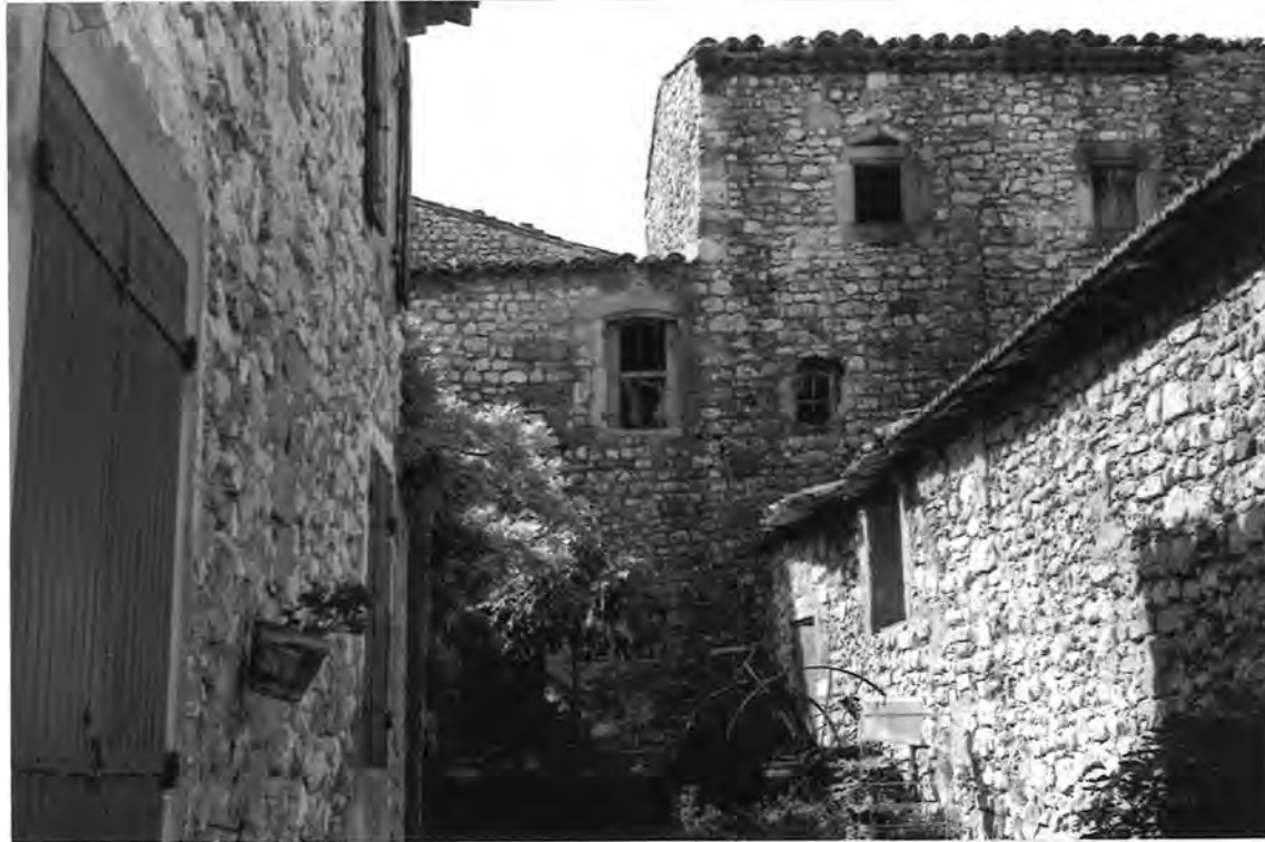
Exemple de bâti en très mauvais état. Patrimoine architectural qui mériterait d'être mis en valeur.
