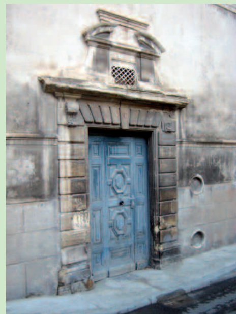
Façade de la prévôté avec sa porte donnant sur la rue du Chapitre
