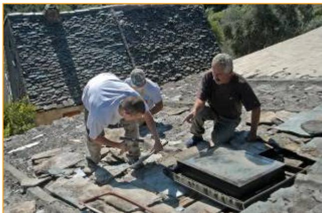
La lauze étant fournie à l'état brut par les carriers, le tittagjhu (couvreur) les choisit, les façonne et les biseaute afin d'obtenir un meilleur ajustement et une épaisseur régulière ; cela permettra d'obtenir, en plus d'un assemblage esthétique, moins de prise au vent et évitera la remontée d'eau par capillarité.
