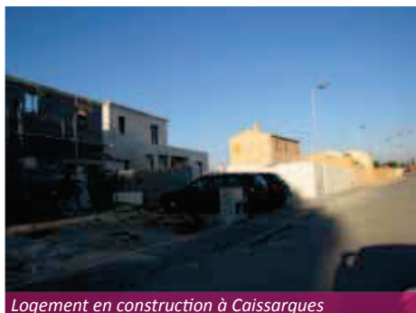
Logement en construction à Caissargues
