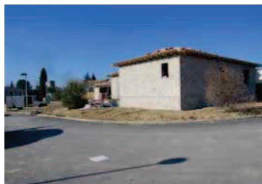
Lotissement en cours de réalisation à Clarensac
