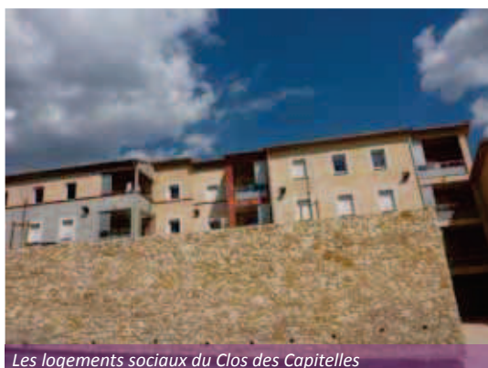
Les logements sociaux du Clos des Capitelles
