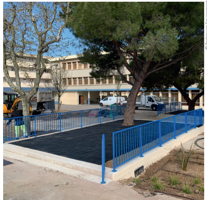
Les dalles 'GrassWay' (Partenaire Equipement), installées facilement par la régie d'une collectivité, ne nécessitent ni terrassement ni fondations préalables.
