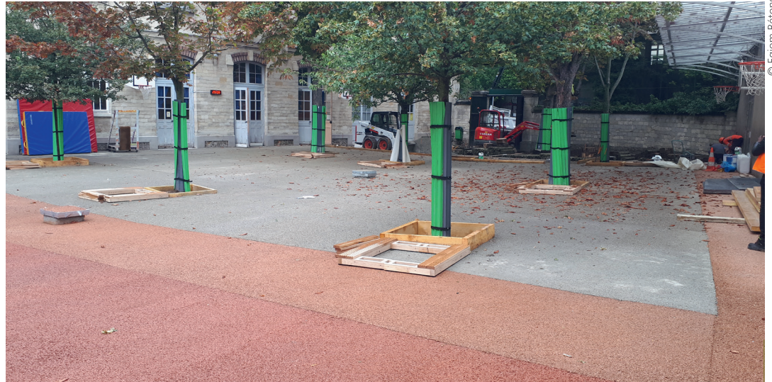
L'asphalte peut être remplacé par du béton drainant coulé en place (solution Aquacimo Drainant de la société Eqiom Bétons). Il a la propriété de drainer les eaux de pluie jusqu'au sol et d'éviter ainsi la saturation des réseaux, tout en limitant les îlots de chaleur.
