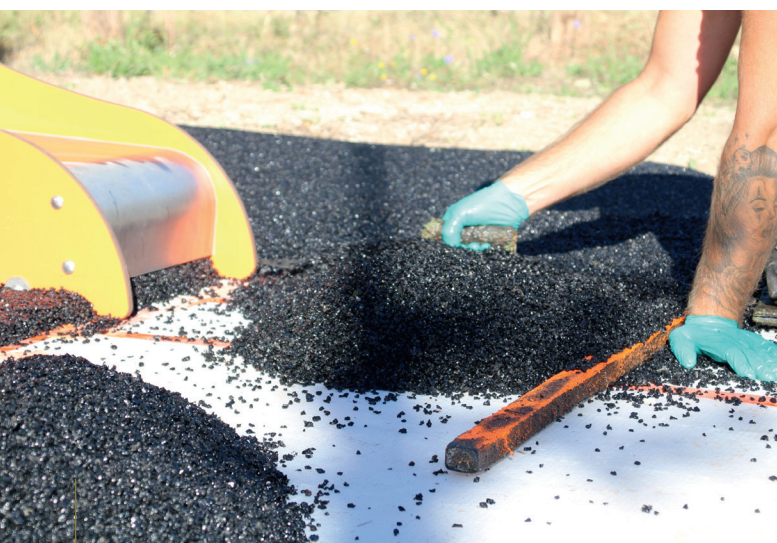
Les grandes plaques en nid d'abeille, type Nidagreen de Nidaplast, sont composées à 95 % de vide. Posés sur le terrain naturel, ces modules assurent un drainage parfait sous le sol synthétique.
