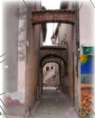
2) Arceaux, Rue des Carrières.
