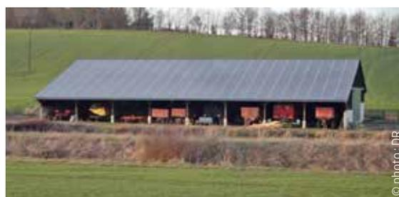
Sur ce hangar, les panneaux photovoltaïques couvrent la totalité d'un pan de toiture.
