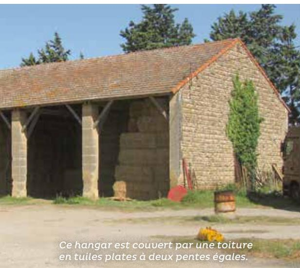
Ce hangar est couvert par une toiture en tuiles plates à deux pentes égales.
