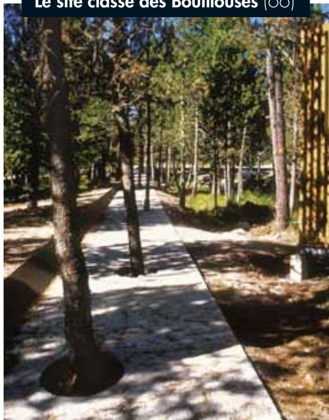
Vue du chemin, une bande de béton de 620 m de longueur, sur 2 m de large et délimité par une bordure en acier Corten.
