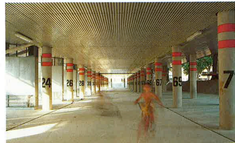
... deux vaisseaux élevés sur les pilotis des parkings.
