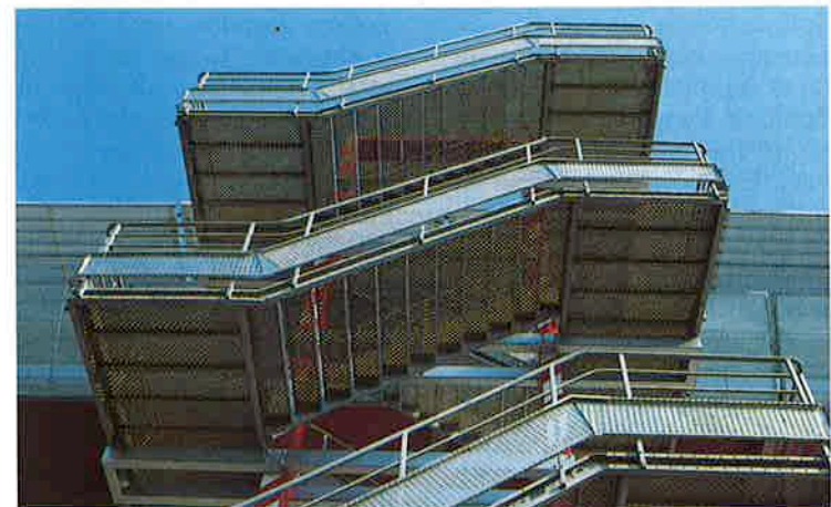
... avec des coursives, des escaliers métalliques ;
