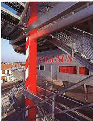
Escalier extérieur. // External stairway.
