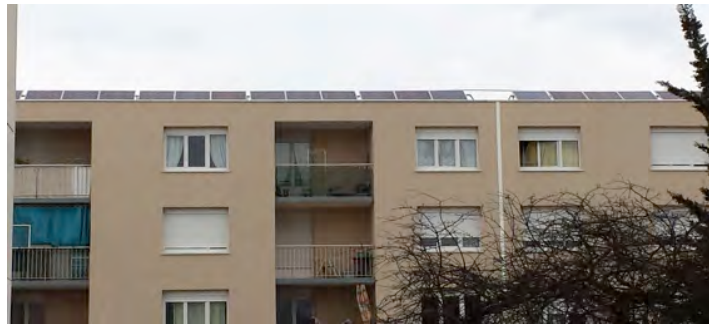
Installation de panneaux solaires sur un immeuble du Coudoyer.
