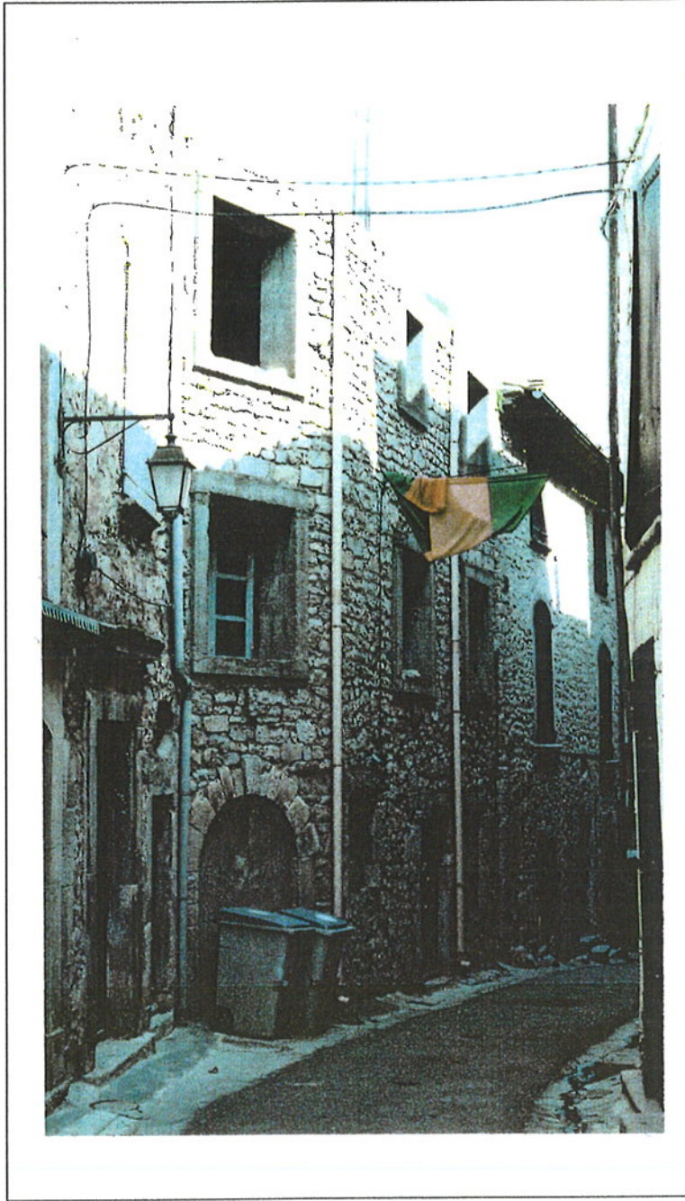
Une façade qui aurait mérité un enduit et dont les encadrements en béton sont disgracieux.
