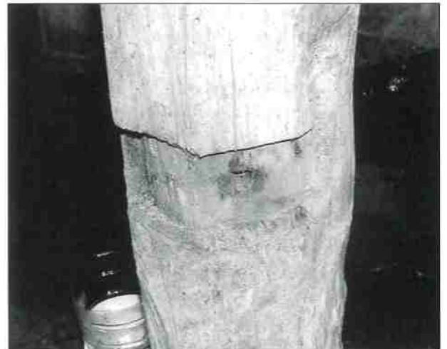
Photo 4. - Entaille de la potence basse dans le pivot.
