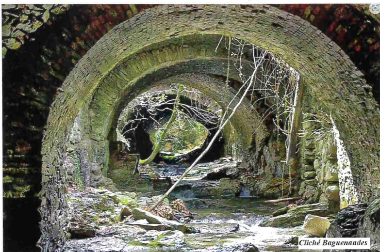
La voûte située sous l'usine dans son état actuel.
