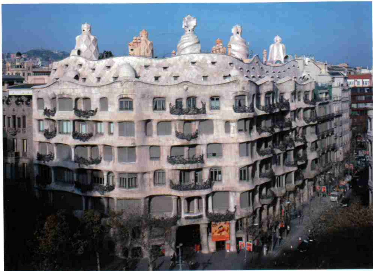
Casa Milà, 1906-1910, quartier de l'Eixample, 92 passeig de Gràcia, Barcelone
