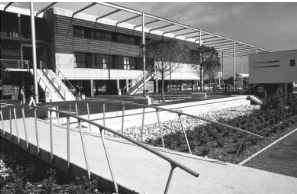
Nîmes. Le lycée Philippe-Lamour Bâtiment principal. Façade sud sur jardin
