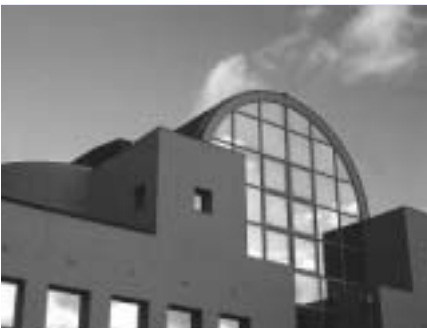
La Roche-sur-Yon Service départemental d'incendie et de secours - SDIS
