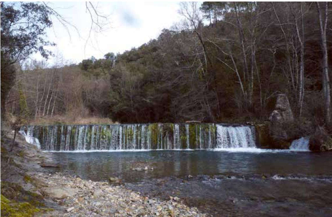
Pansière à Pie de Nieu : le seuil aménagé oblige l'eau à s'échapper dans le béal en rive gauche (à droite sur la photo) ; quand le béal est fermé, comme ici, l'eau revient dans le lit principal par une évacuation tumultueuse.
